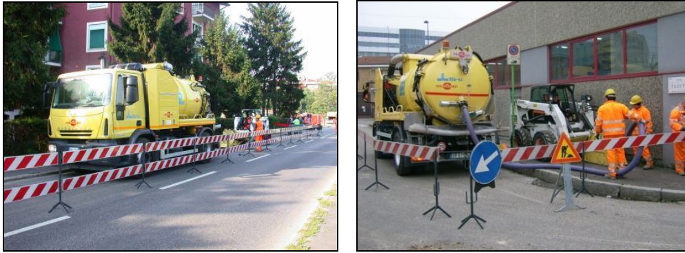
Fig.B.14. - Cantiere mobile 1DD™ per minitrincea in area urbana a Milano
